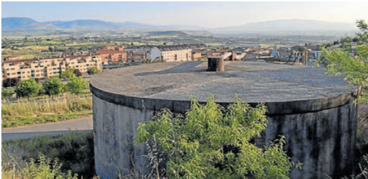
El actual depósito municipal de agua de Villamediana de Iregua. D. M. A.
