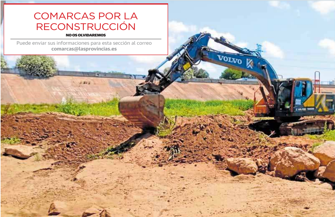
Una excavadora en pleno trabajo en el nuevo cauce del Turia. LP
